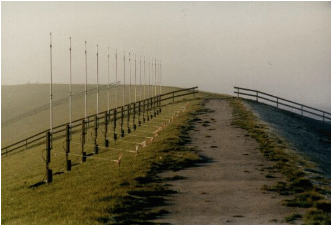
Abbildung 1.1: Array aus 16 Antennen, linear angeordnet parallel zur Küste; links die Landseite, rechts die Seeseite.
